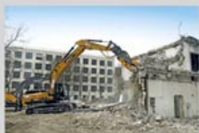
f scavi e demolizioni
